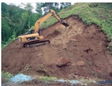
法面工事安全管理
