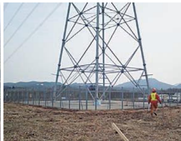
切土工事安全管理
